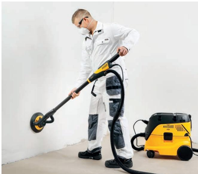
Combina a Mirka® LEROS ou LEROS-S com os abrasivos de rede sem pó da Mirka® e um sistema de extração de pó adequado para criar um ambiente de trabalho mais limpo e saudável.
