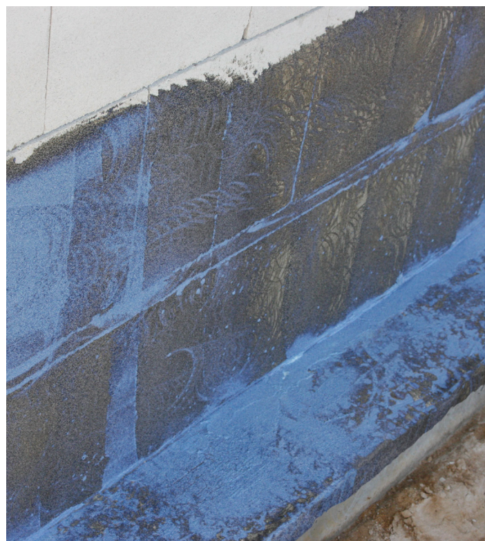
Alteração da cor da aplicação da pasta com espátula utilizando MB 1K rapid
